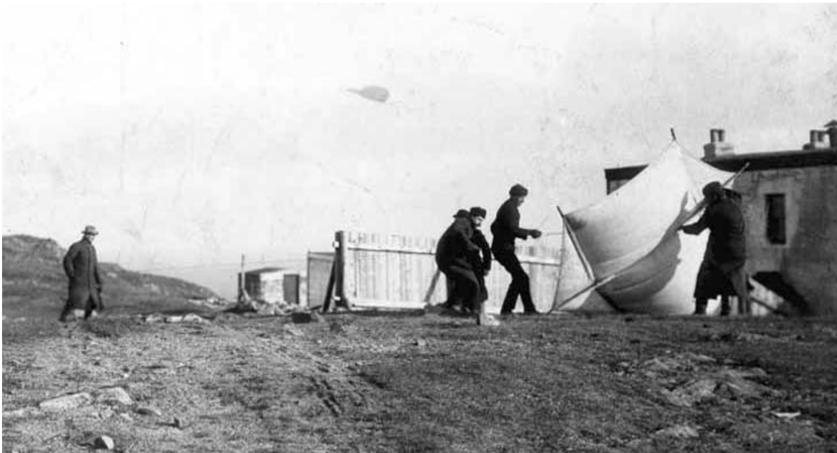
Fig. 49 - Dicembre 1901. Marconi (a sinistra) ed i suoi assistenti a Signal Hill, mentre alzano l'antenna della stazione ricevente con gli aquiloni.
