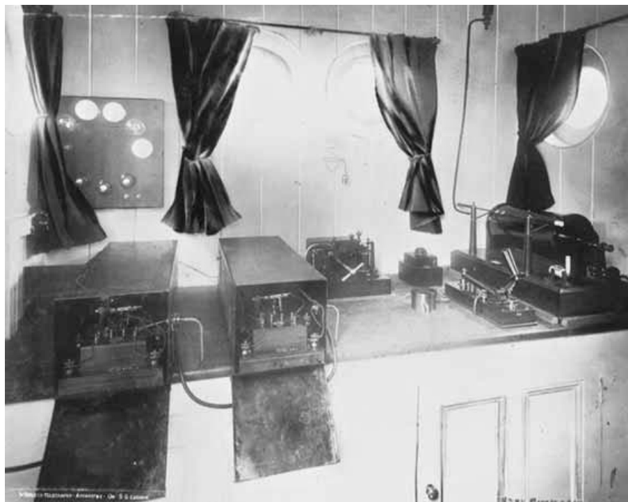
Fig. 67 - Cabina radio installata a bordo del piroscafo Lucania , in cui nel 1903 Marconi riceve messaggi da Poldhu e da Cape Cod che sono stampati sul "radiogiornale" di bordo.
