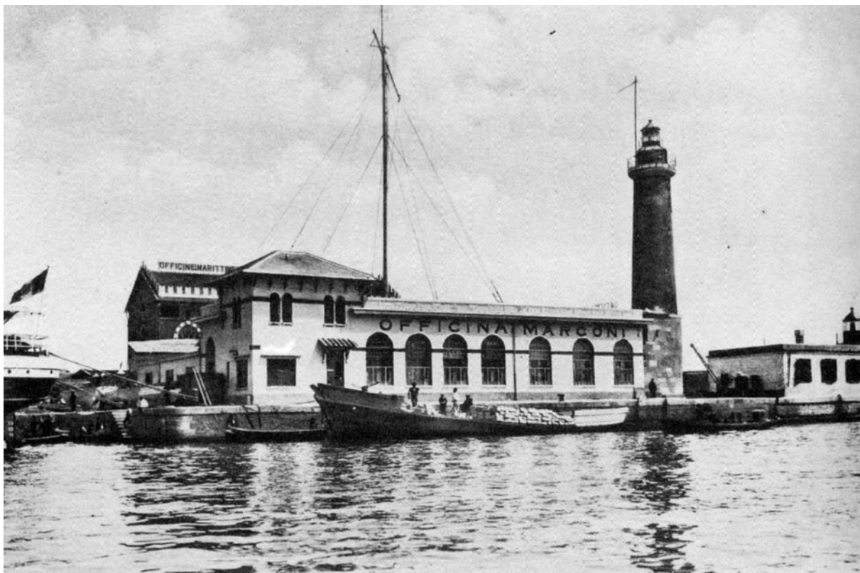
Fig. 83 - Stazione radiotelegrafica di Genova (con l'antenna sull'edificio) e Officine Radio Marconi in cui si costruiscono gli apparecchi radiotelegrafici.
