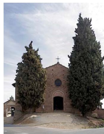
Veduta della Chiesa di San Sebastiano
