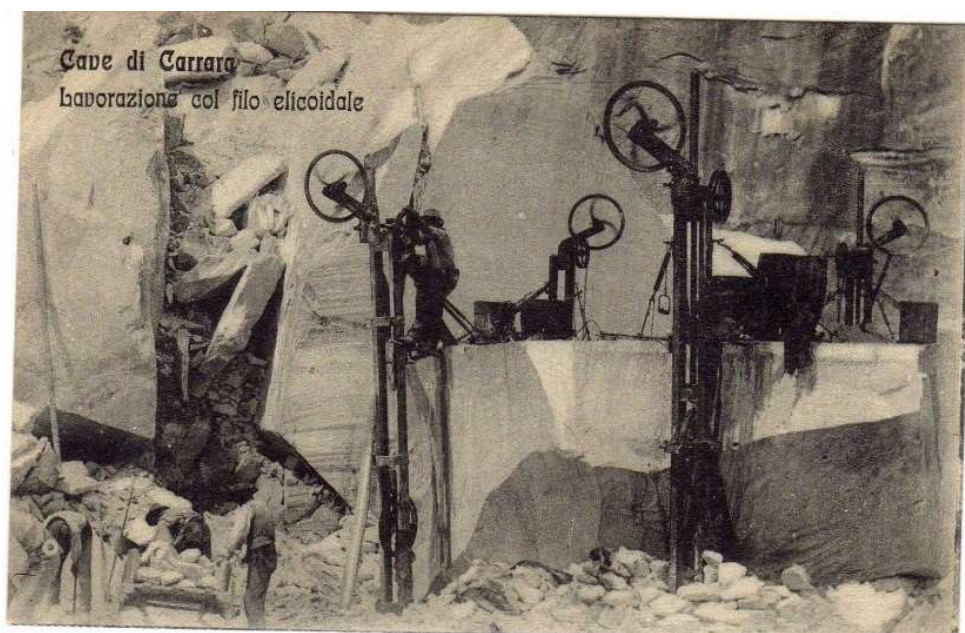
1910 Cave di Carrara - macchina lavorazione dei marmi col filo elicoidale
