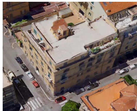
Veduta aerea via Ombrone angolo via Arno
